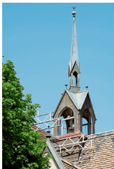
Der Kirchliturm wird ausgerüstet.
